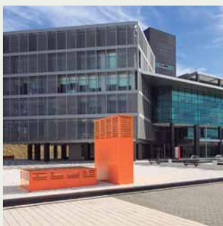
Andalucia-teknologipark. Kontorer med høy energieffektivitet. Spania. ECOi
